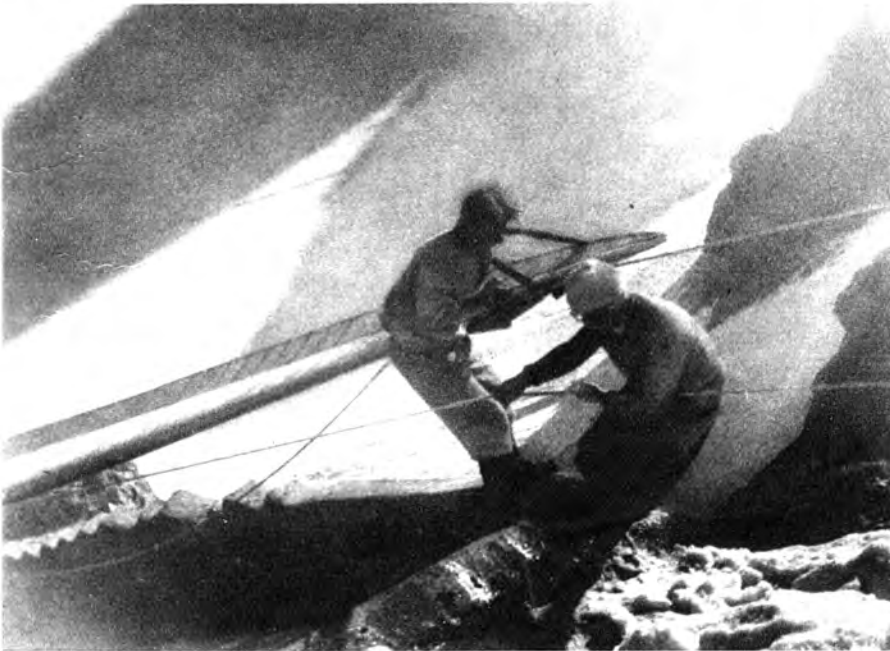
Der andere Flügel folgt. Unter großer Vorsicht werden die einzelnen Teile aneseilt und hinaufgezogen.
